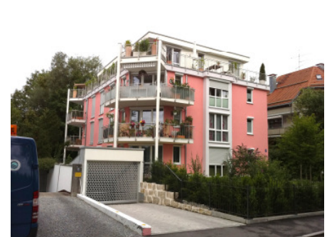
München-Thalkirchen Am Isarkanal 18
